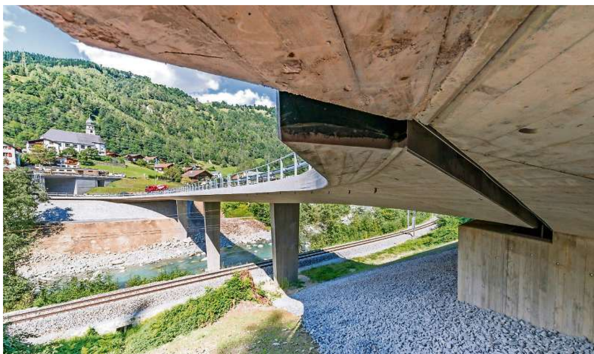
Bei den Anschlüssen an das bestehende Strassennetz weiten sich die beiden Enden der neuen Vorderrheinbrücke Danis trompetenförmig aus. (FOTO TIEFBAUAMT GRAUBÜNDEN)
