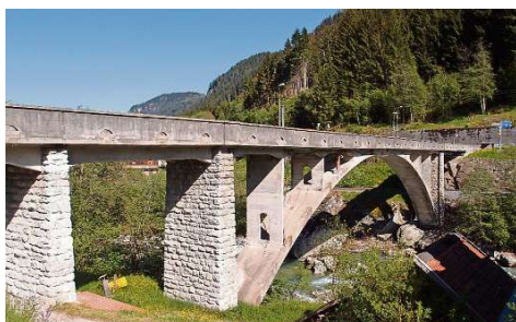
Die im Jahr 1928 erbaute Versellbrücke verbindet die Orte Danis und Tavanasa über den Vorderrhein. (FOTO ZVG)
